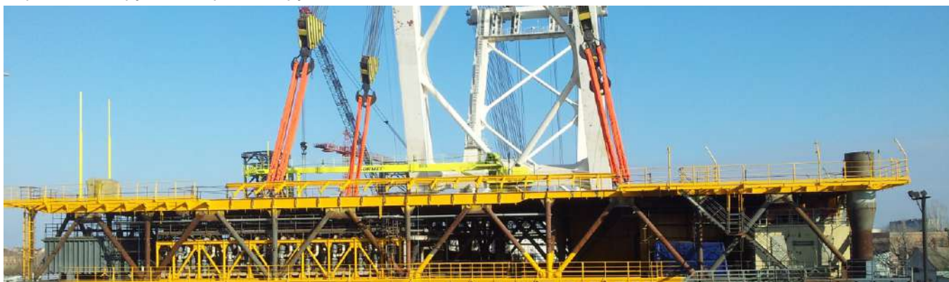
Использование круглопрядных стропов при отгрузке верхнего строения буровой платформы (вес 2450 т).
